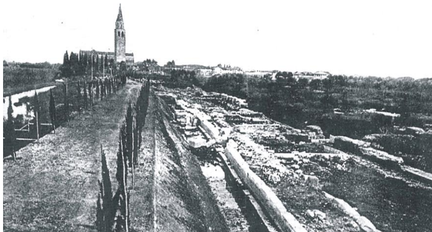
Realizzazione della Via Sacra
