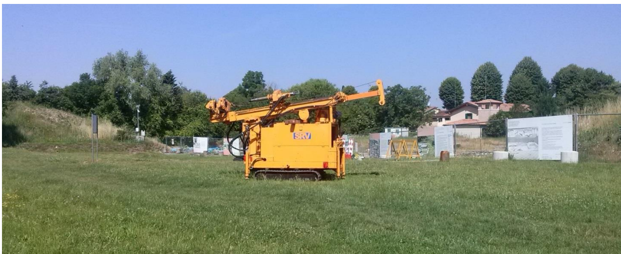
Perforatrice A30 – cantiere Fondo Cossar
