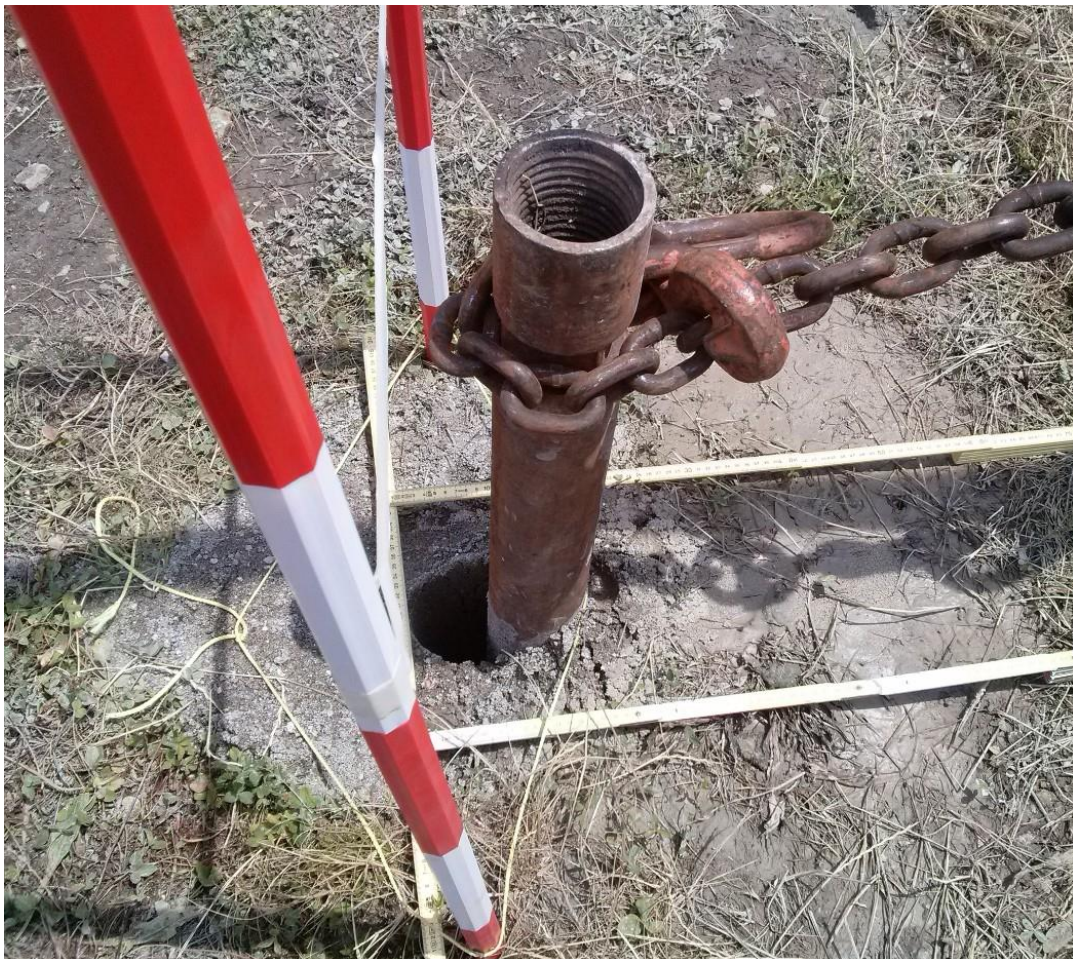
Prova di carico rifiuto
