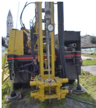
Esecuzione prova CPT in foro
