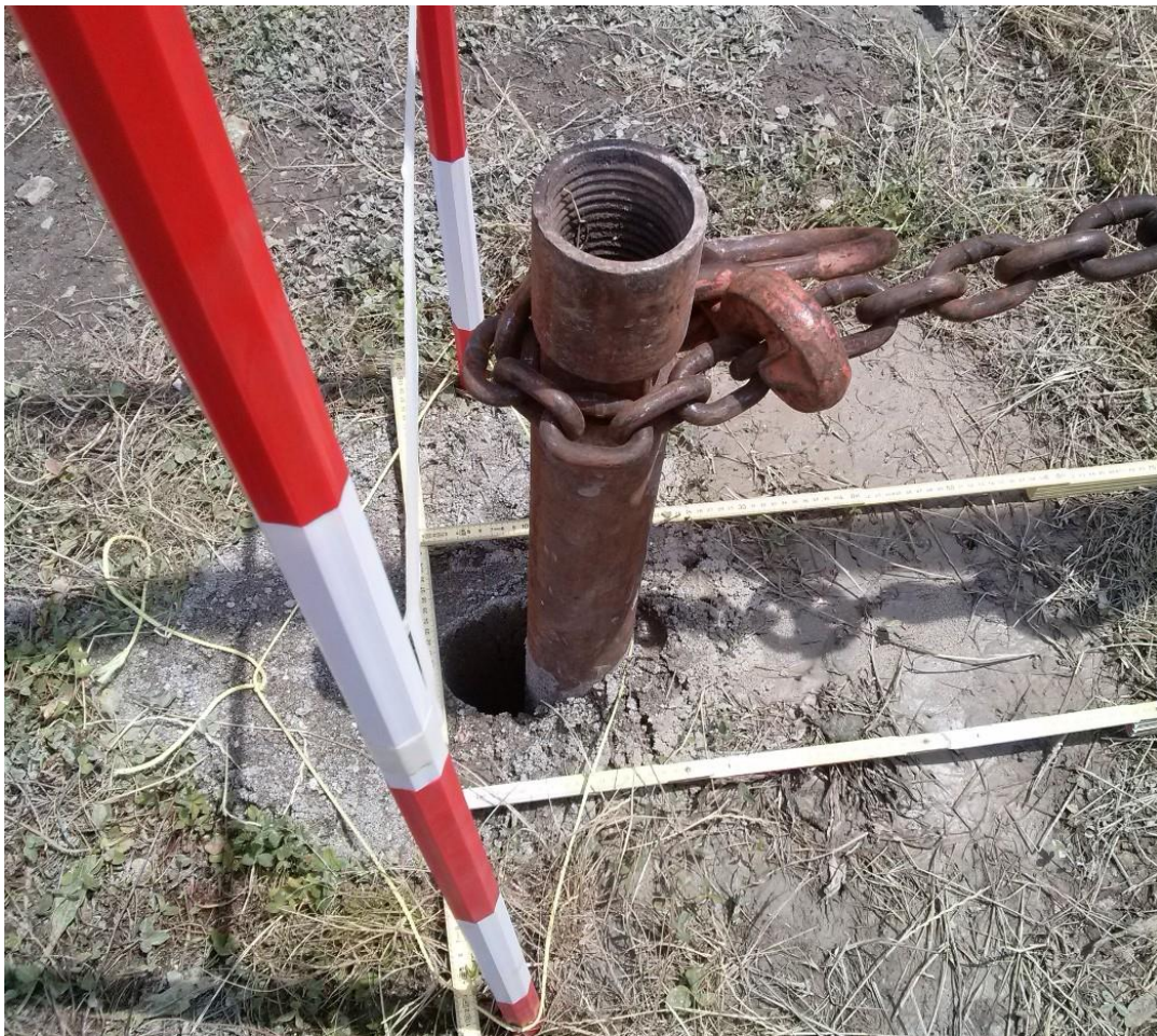
Prova di carico rifiuto
