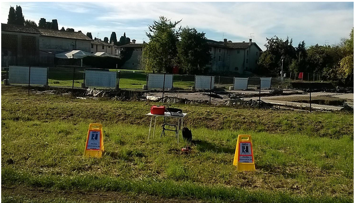
Esecuzione indagine sismica MASW e HVSR
