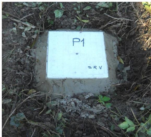
Pozzetto piezometro P1
