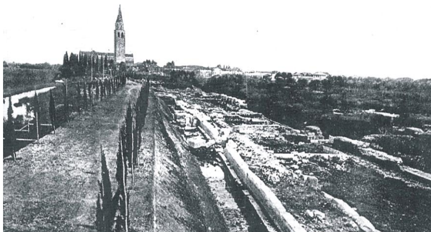
Realizzazione della Via Sacra
