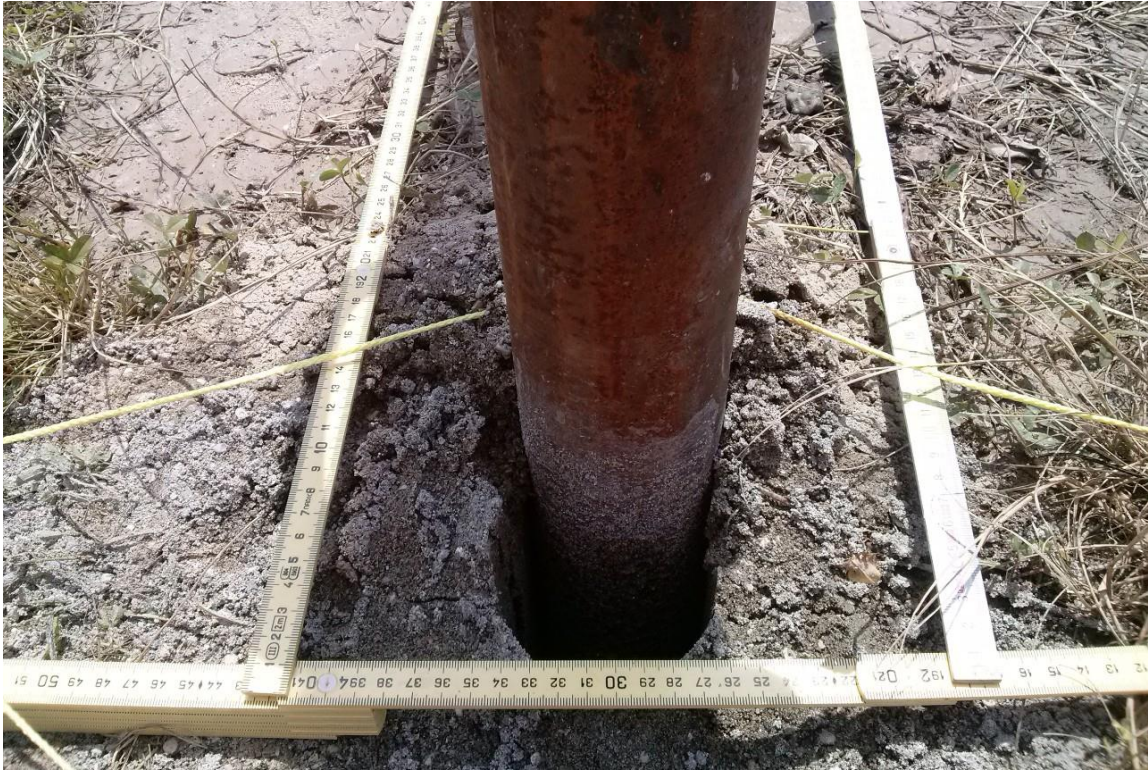
Prova di carico rifiuto
