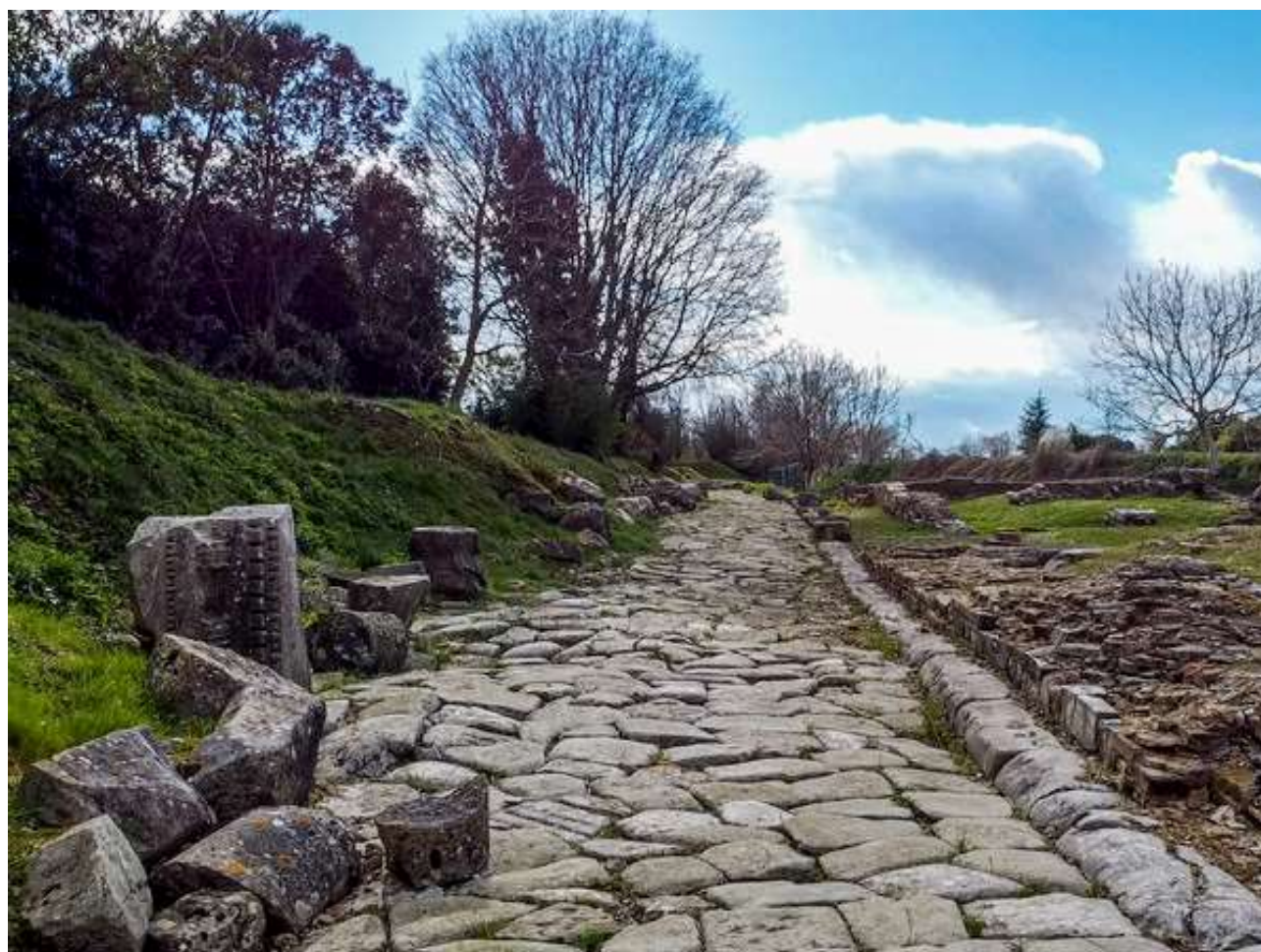
Figura 10: l'intervento realizzato nel decumano di Artria Galla
